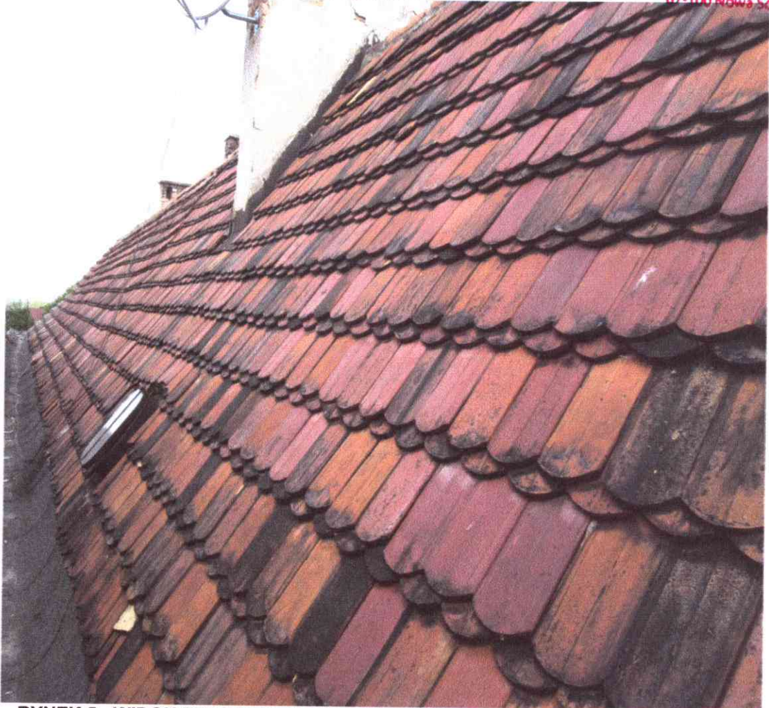
RYNEK 5 - WIDOK FRAGMENTU POŁACI DACHU OD STRONY BUDYNKU RYNEK 4
