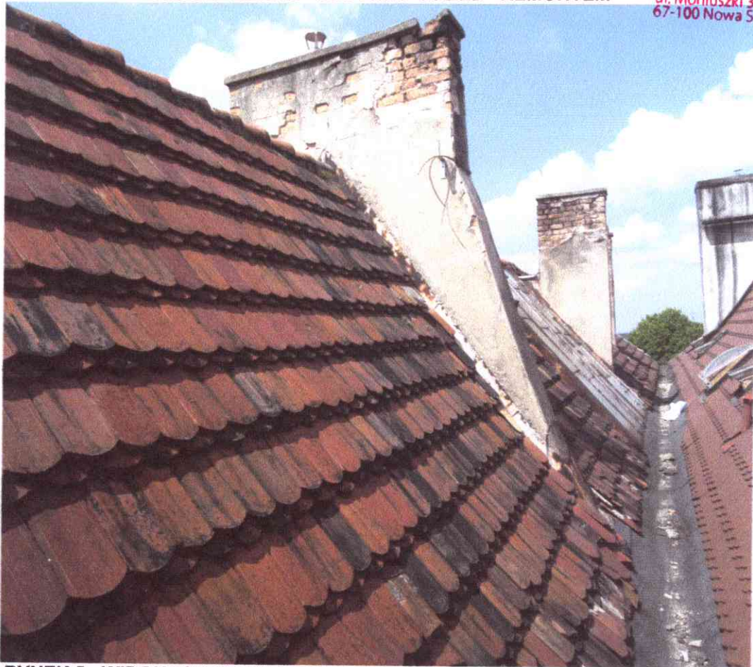
RYNEK 5 - WIDOK FRAGMENTU POŁACI DACHU OD STRONY BUDYNKU RYNEK 6
